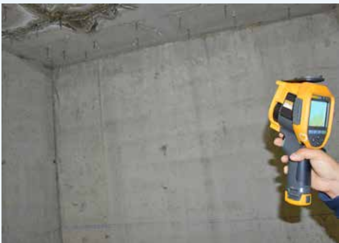
Durante un rilievo termografico
